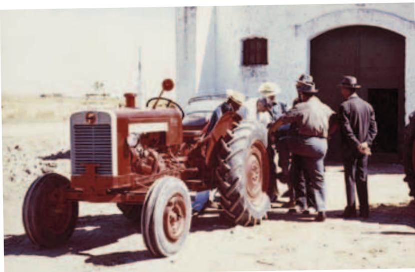
Ein portugiesischer FAP 361 D. Die technischen Details waren den original finnischen Modellen sehr ähnlich, allerdings erweitert um Vorder- und Hinterradgewichte aufgrund der harten Böden in Portugal. Der Dreizylinder-Motor hatte 46 PS und das Getriebe sechs Vorwärts- und zwei Rückwärtsgänge.
