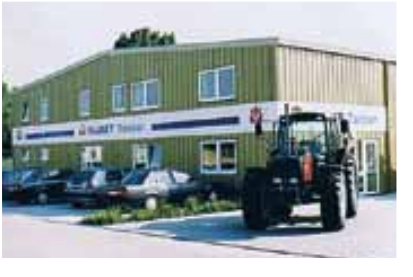
Die erste Zentrale der Valmet Traktoren GmbH in Ergolding bei Landshut.
