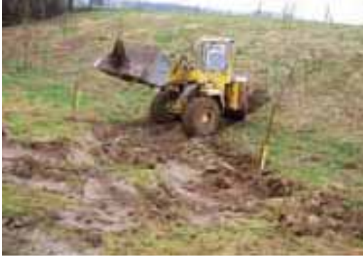
Der Radlader ist im Schlamm völlig festgefahren.
