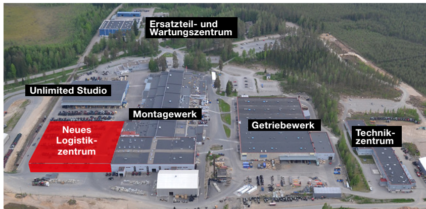
Das neue 8.000 m 2 große Logistikzentrum entsteht im Bereich zwischen dem Montagewerk und dem Unlimited Studio.
